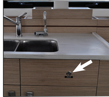
INTERRUPTOR DE BOMBA DE AGUA DE MAR
