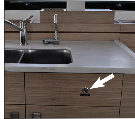
INTERRUPTEUR DE POMPE EAU DE MER
