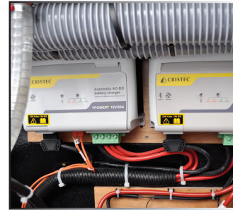
CHARGEURS DE BATTERIE
