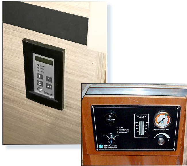
MANDOS DE LA DESALINIZADORA
