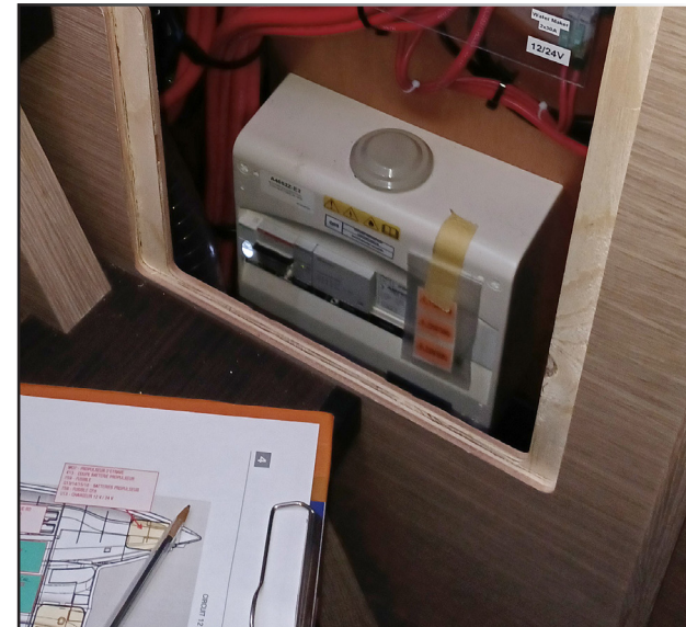
DISYUNTOR DEL CONVERTIDOR 12 V / 220 V - 2000 VA
