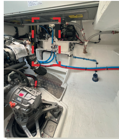
LOCAL MOTEUR TRIBORD 5
