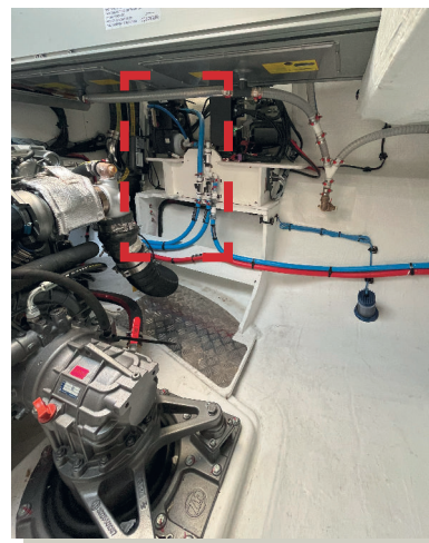
LOCAL MOTEUR TRIBORD
