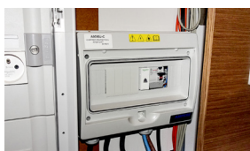
Disj. Diff. 230 V Sortie Convertisseurs Réfrigérateur Principal
