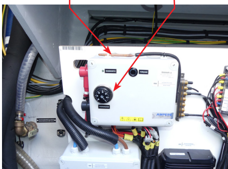
Ajustement Température de Coupure
