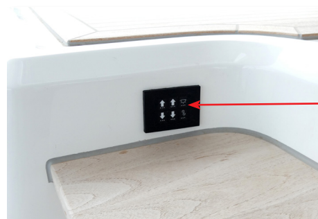
Commandes Trappe en Bas de l'Escalier
