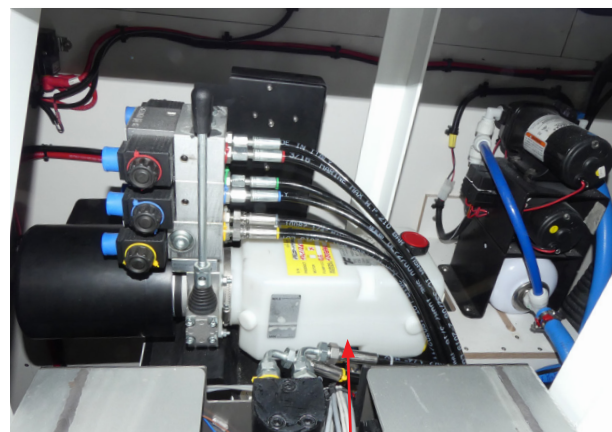
Groupe Hydraulique de la Passerelle
