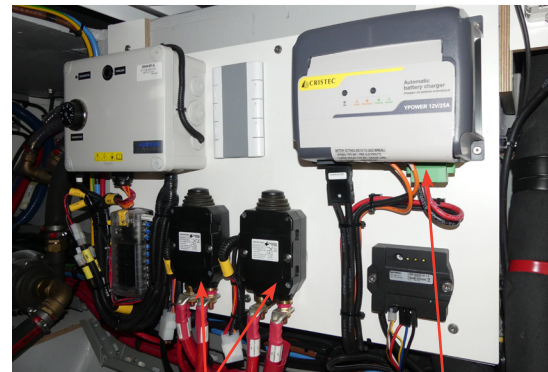
Coupe-batterie Moteur BB et Contacteurs de Couplage K28-K31
