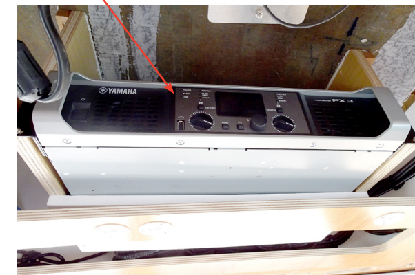
Amplificateur de Puissance Sono Salon dans Plafond (à bâbord)
