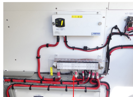
Bus Service 24V X23-X24 et fusible de protection 200 A F35
