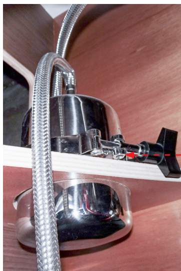
Purificateur d'Eau Potable
