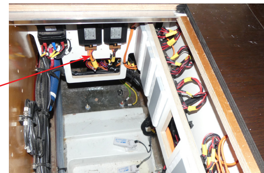
Modules Bloc 7 Cale Centrale Bâbord
