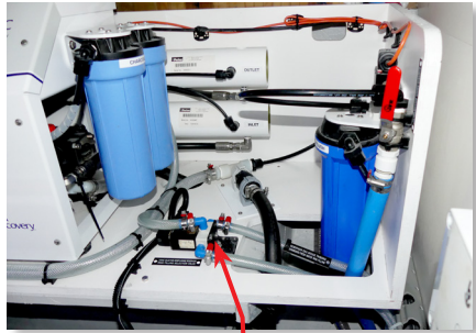
Électrovanne 3 voies : Production vers Réservoir Sélectionné
