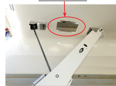
Refoulement du Conduit sous le Ponton
