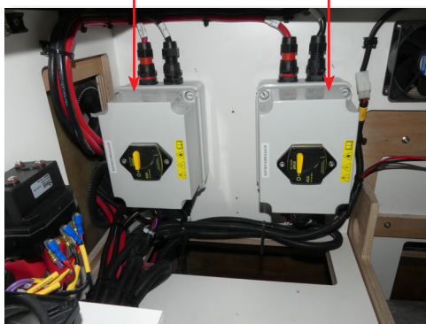
Disjoncteur Thermique 40A - Solent
