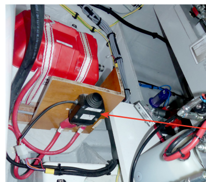
Batterie Générateur TB et Coupe-batterie K24
