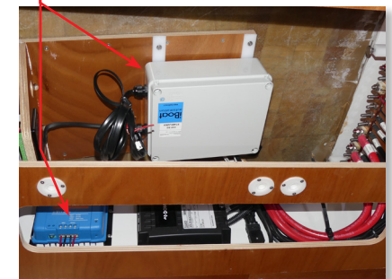
Boite Alimentation Lift TV Salon & Filtré Égaliseur 24/24 V
