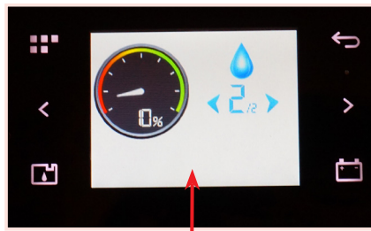
Niveaux des réservoirs d'eau douce sur l'écran Navicolor
